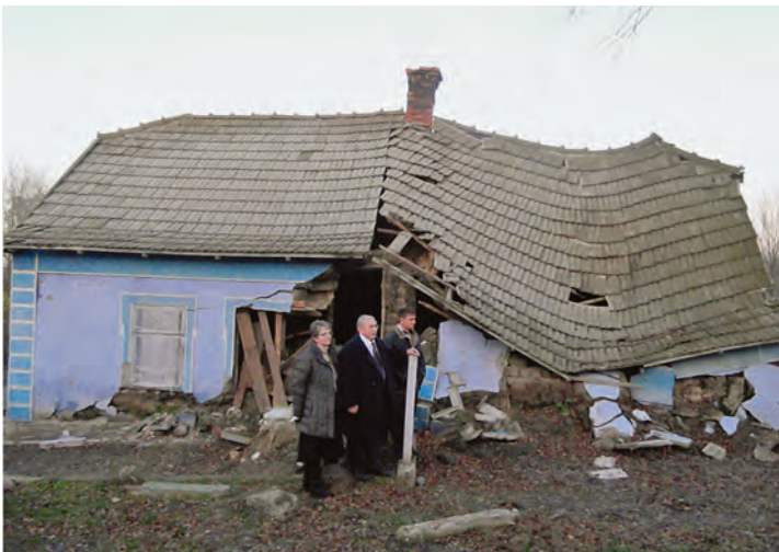
Der Bürgermeister zeigt uns die Zerstörung.
