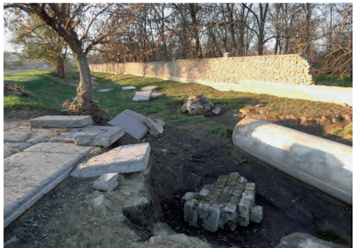
Schwere Betonteile wie Bretter mit Leichtigkeit weggespült und weit verstreut.
