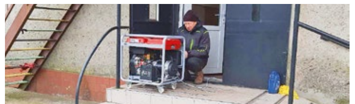
Inbetriebnahme des Generators
