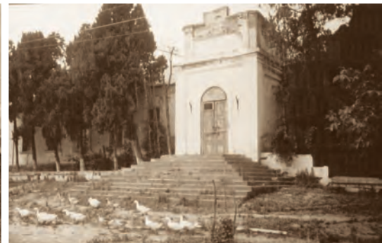
Reste des Kirchturms 1973
