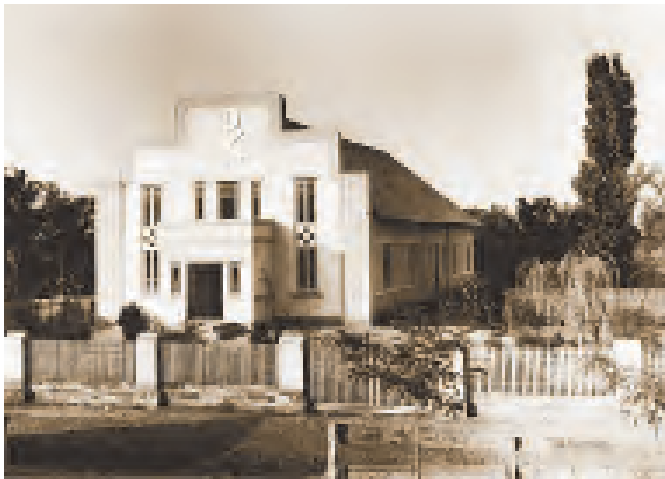
„Unser Heim“, fertiggestellt 1938, Foto aufgenommen 1940
