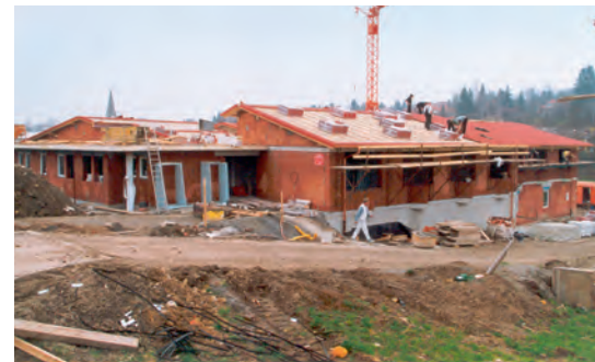
Neubau des ersten Gemeindepflegehauses in Weissach im Tal
