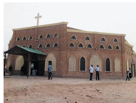
Kirche nach der Erweiterung (Foto 2)
