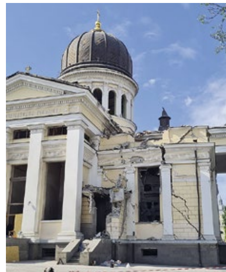
Die schwer beschädigte Verklärungskathedrale von Odessa. Foto: Privat
