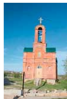
Die neue Kirche in Leipzig ist noch nicht ganz fertig gestellt
