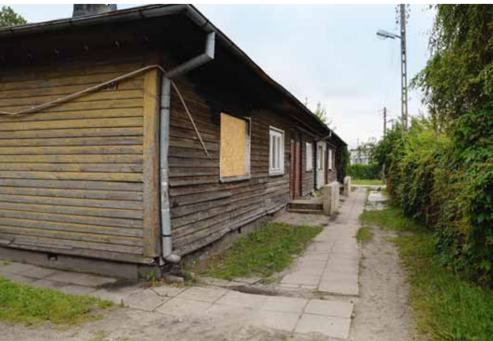
Lager Wendener Straße, Lodz
