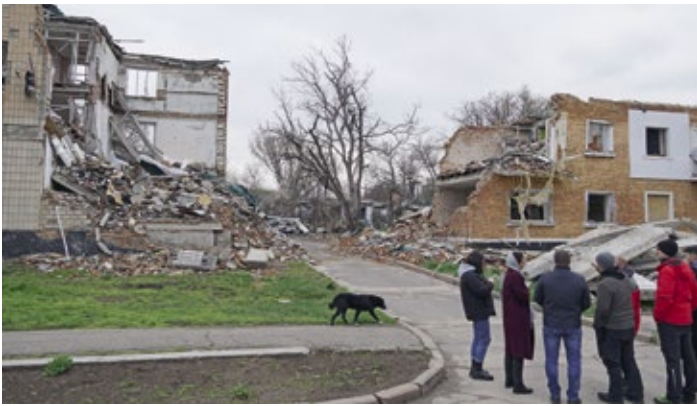
In Baschtanka haben die russischen Truppen im Vorbeifahren Gebäude und Einrichtungen zerstört
