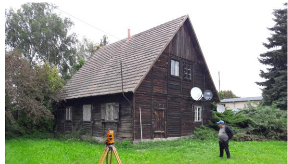
„Besarabka“ – solche Fertighäuser erinnern an die bessarabiendeutschen Ansiedler in Polen
